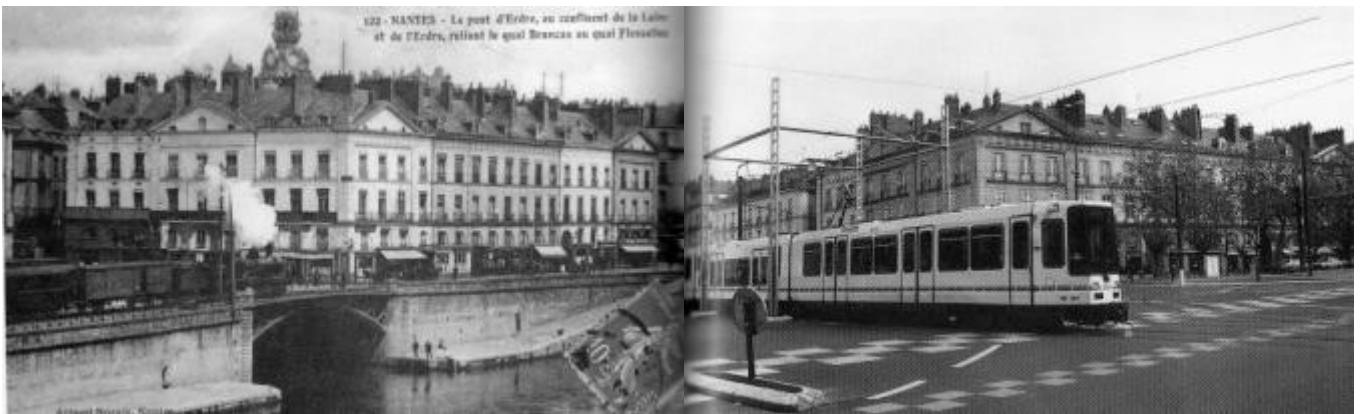
Confluence de l'Erdre et de la Loire avant les comblements...et aujourd'hui !
